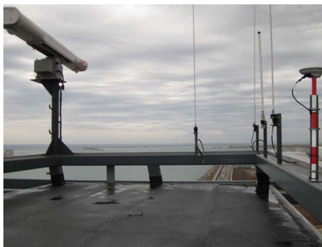
La antena Leica AX1202 GG es capaz de realizar un seguimiento constante de las constelaciones NAVSTAR y GLONASS así como de la futura constelación GALILEO.
